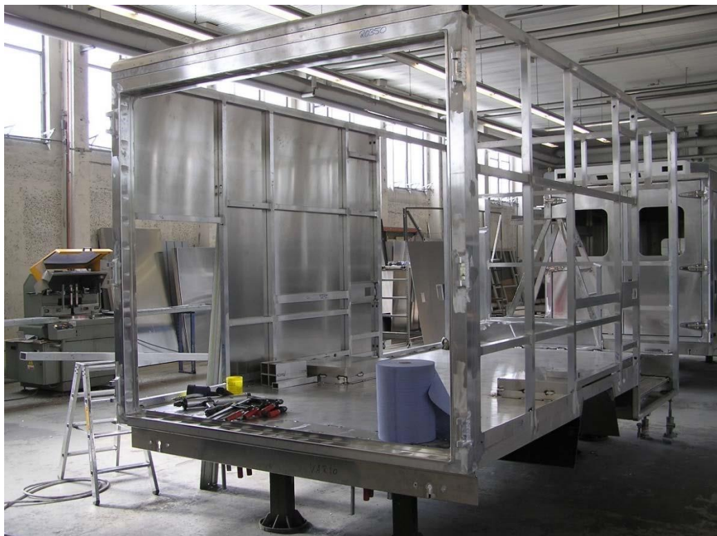
(Aufbringen der Seitenwand links)
